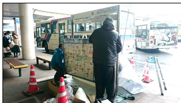
図5：設置作業（2018年3月20日）
